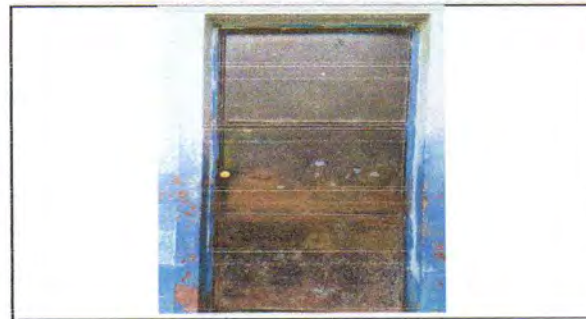
FOTO 18: Pintura en muros exteriores e interiores
