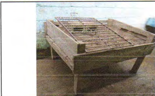
FOTO 13: Sustrucción de estufa rural (completa) incluye chimenea y plancha de metal
